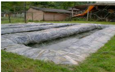
Figura 19 - Pequeno sistema de tratamento da água residuária da lavagem e despolpa do café.
