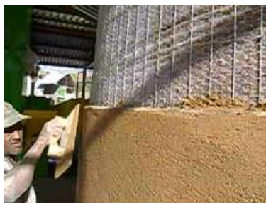
Figura 46 - Revestimento externo do silo secador-armazenador com argamassa.
