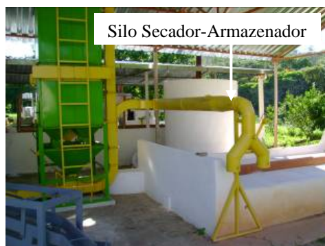
Figura 36 - Unidade de secagem combinada construído e instalada no DEA-UFV (capacidade de 2.500 L por dia).
