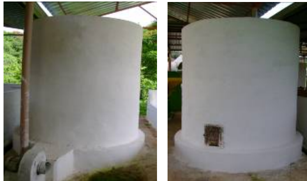
Figura 48 - Silo depois de pronto mostrando ventilador e porta de descarga.
