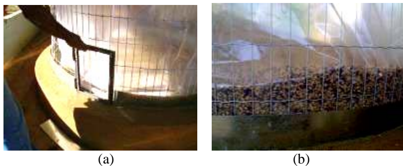
Figura 45 - Silo secador-armazenador: (a) colocação da porta para descarga; e (b) enchimento.
