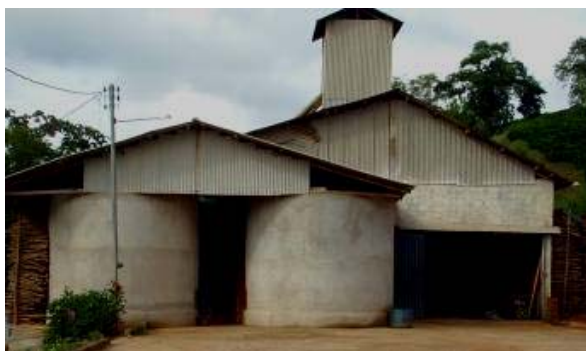
Figura 37 - Vista dos silos para secagem em combinação, na fazenda do professor Sebastião Ferreira (Viçosa - MG).
