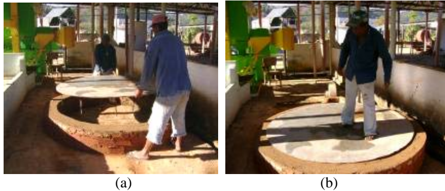
Figura 42 - Montagem da base do silo: (a) colocação do piso perfurado; e (b) piso fixado, formando a câmara plenum .
