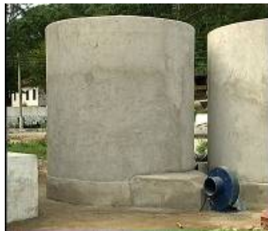
Figura 49 – Silos secadores em fase final de construção, em alvenaria de tijolos.
